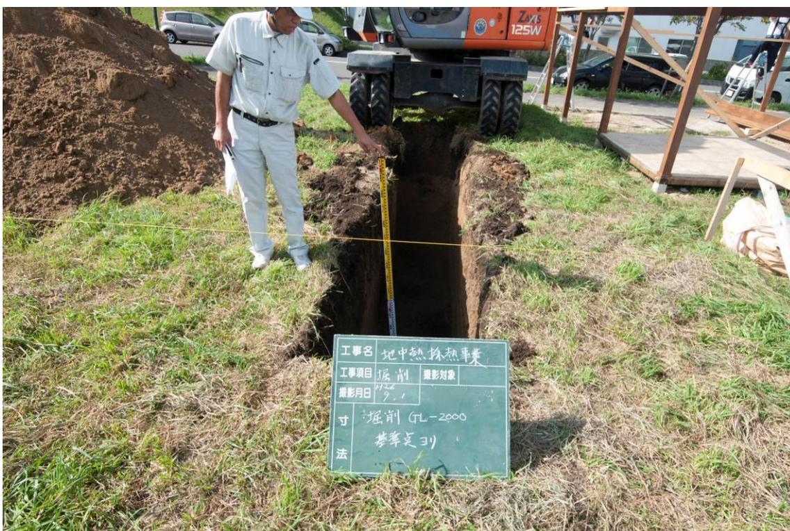
■ 1列め掘削状況（幅80cm×長さ10m×深さ2mにて2列掘削しております）
