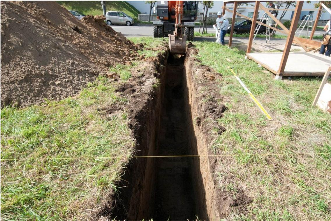
■1 列め掘削状況 （地下水が出水せず順調に掘削できている。出水がある場合は土留めの設置が必要）
