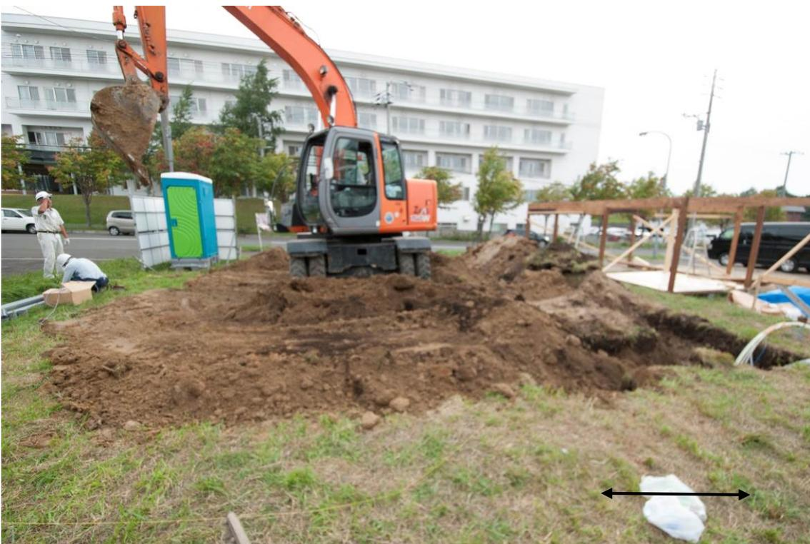
■ 整地作業 ※他の埋設工法とちがい、余剰土が発生しない
