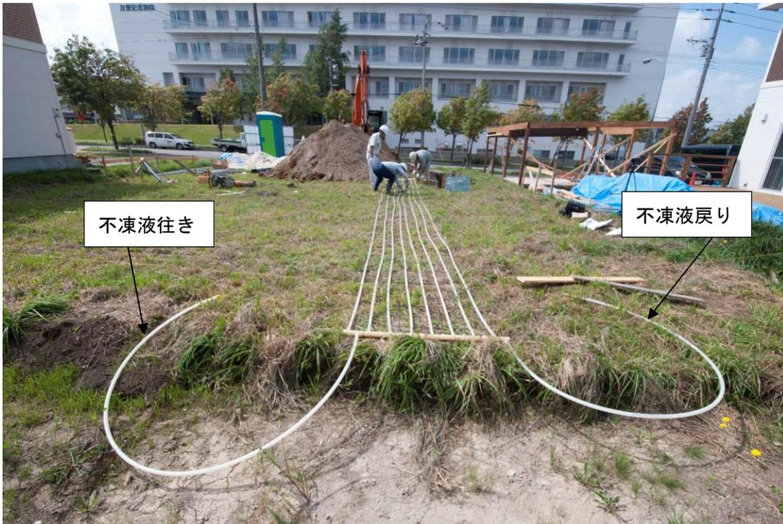
■1 列め柵状熱交換器の埋設準備 (樹脂管をワイヤーメッシュに結束固定している)
